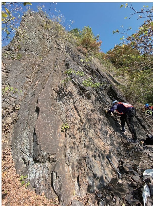
図2. 道後姫塚にある和泉層群の露頭の写真。
